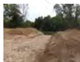
Création de cales de mise à l'eau
